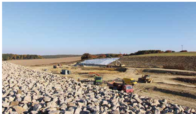
Obr. 5 Aplikácia kotiev a drénov ZUBOR na stavbe D1 Budimír – Bidovce
