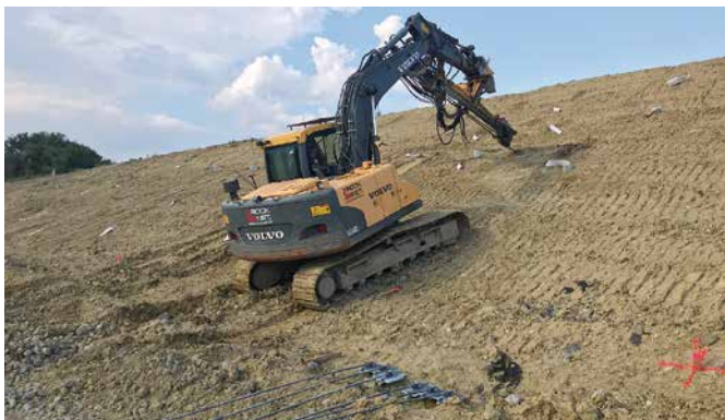
Obr. 4 Zarážanie mechanických kotiev hydraulickým kladivom na pásovom podvozku
