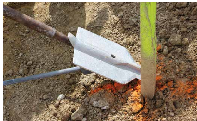
Obr. 2 Mechanická zemná kotva ZUBOR s vodiacou tyčou na zarážanie
